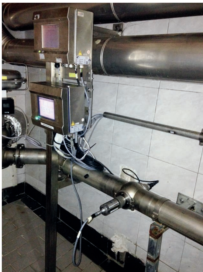
Rys. 2. Przetworniki 410 firmy Hach – typowa instalacja
